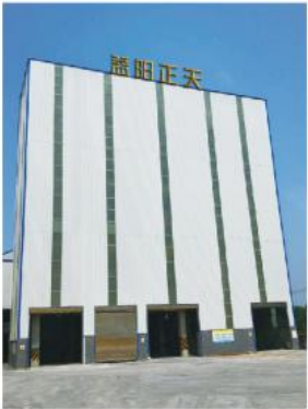
益阳正天60T/h机制砂生产线
