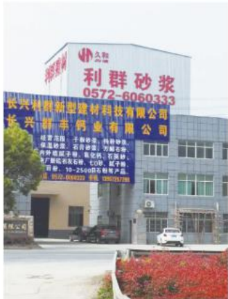
浙江长兴利群50T/h机制砂生产线
